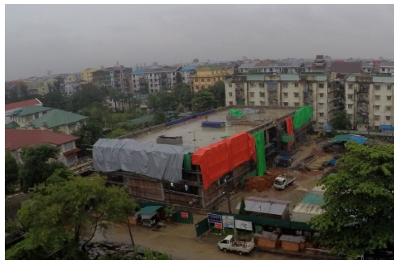
Starker Regen beeinflusst die Arbeiten
