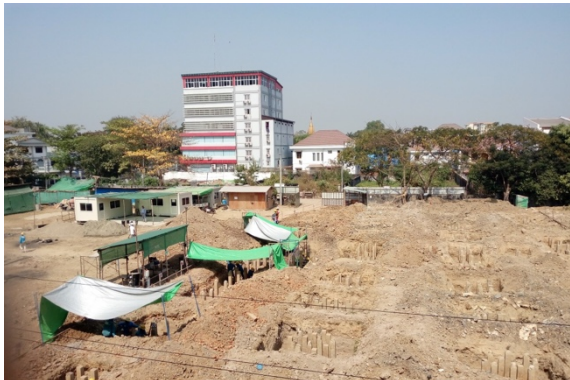
Start der Bauarbeiten im Januar 2018
