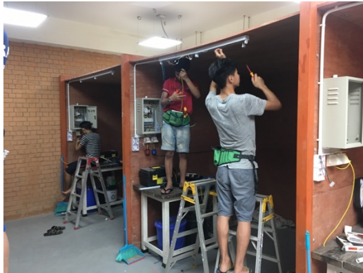
Lernende Elektriker beim Installieren
